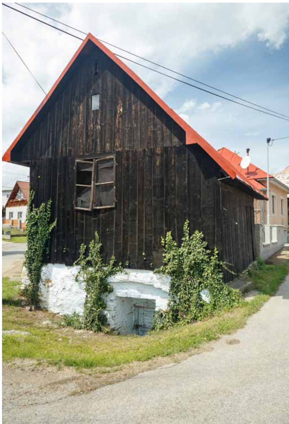
Kurov. Podpivničený sypanec s predsunutým gánkom a bočnou stranou obitou doskami
