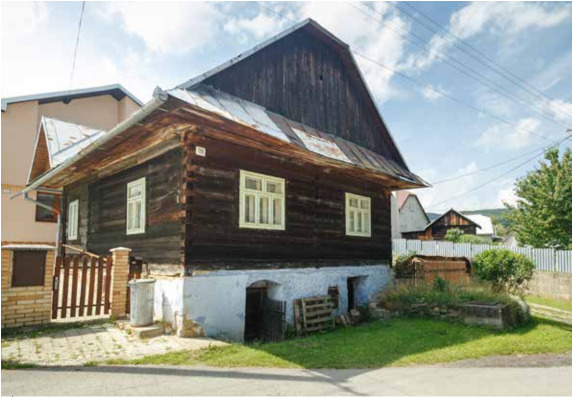
Kurov. Podpivničený zrubový dom s veľkými okennými otvormi už patrí k novším stavbám v obci postavených po 2 .svetovej vojne
