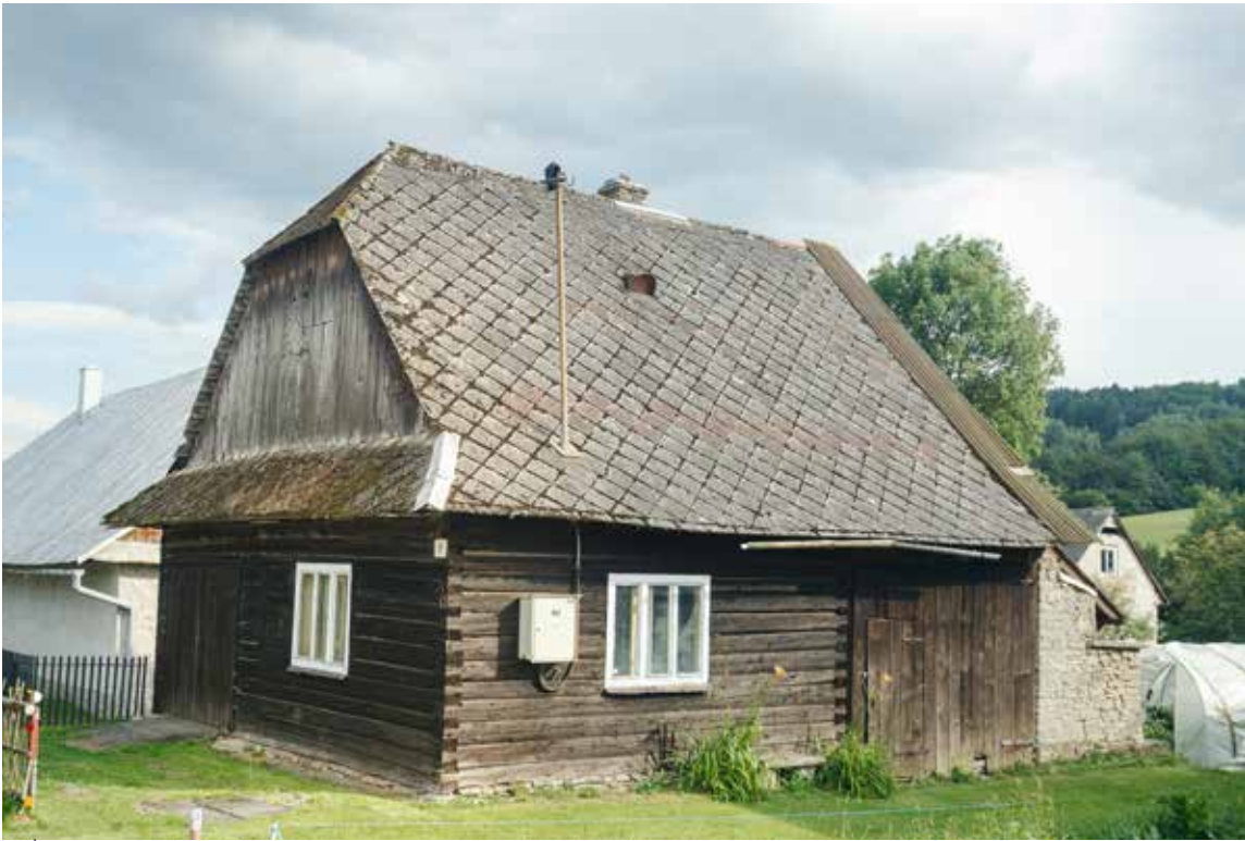
Vyšná Polianka. Zrubový objekt so strešnou krytinou zdobenou viacfarebnými azbest – cementovými škridlami
