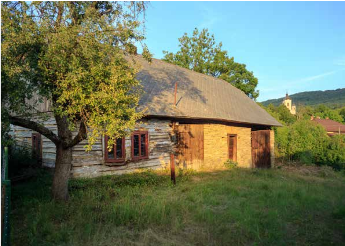
Becherov. Zrubový dom makovického typu s kamennou hospodárskou časťou
