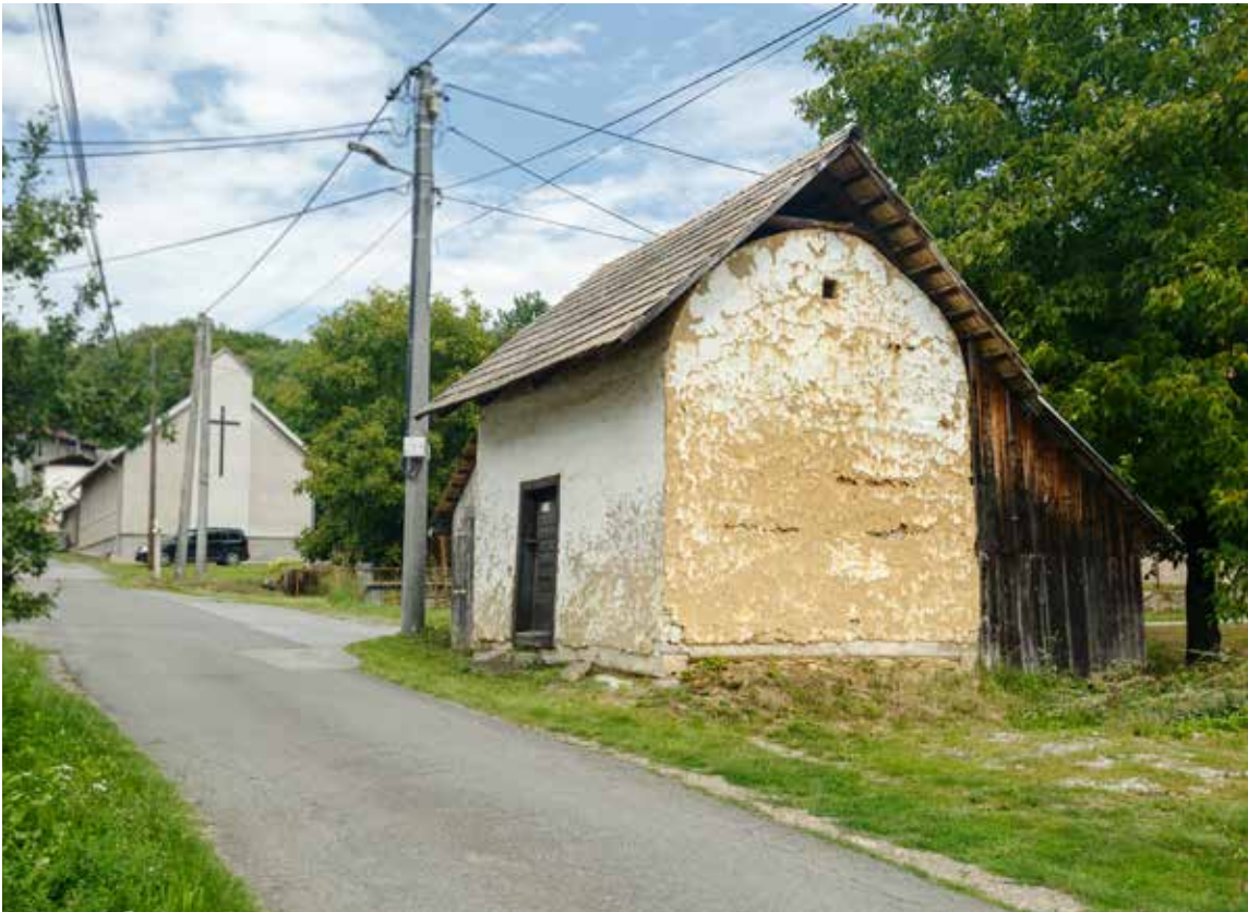
Mokroluh. Sypanček so šopkou, omietnutý ilom s plevami a nafarbený vápenným náterom
