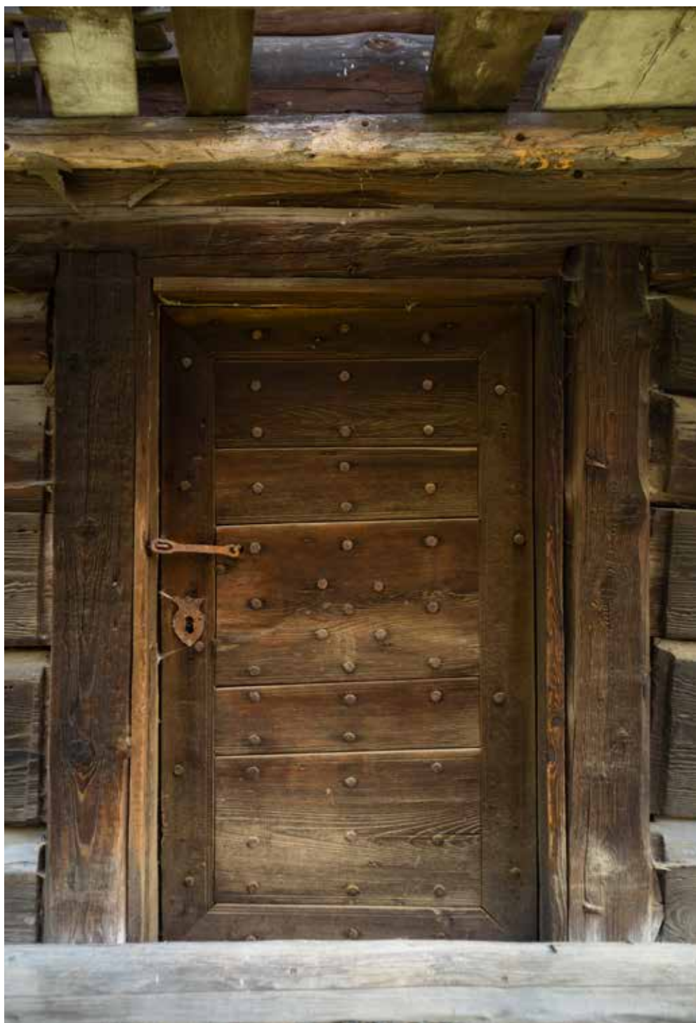
Frička. Rámové dvere sypanca boli v minulosti jediným objektom na gazdovstve zamykaným na kľúč
