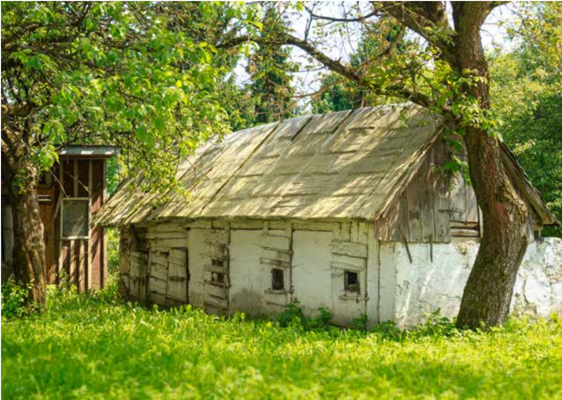
Frička. Chlievy a kuríny postavené tradičnou zrubovou technikou
