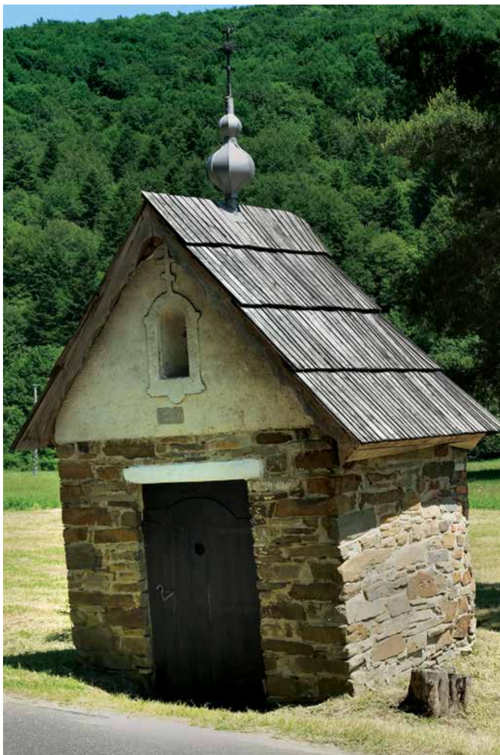
Rozstajne, spádová obec Kremplna. Domová kaplnka
