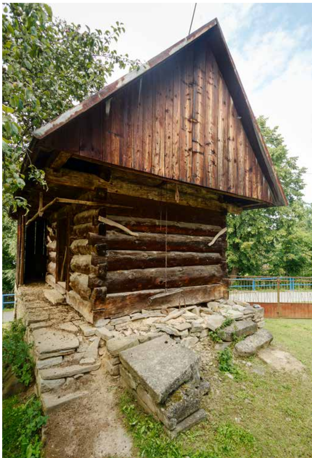
Becherov. Sypanec s predsunutou strechou vytvárajúcou krytý pracovný i oddychový priestor
