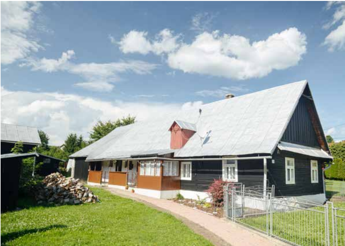
Nižná Polianka. Dom č. 44. Ukážka povojnovej zrubovej architektúry z 50. rokov 20. storočia
