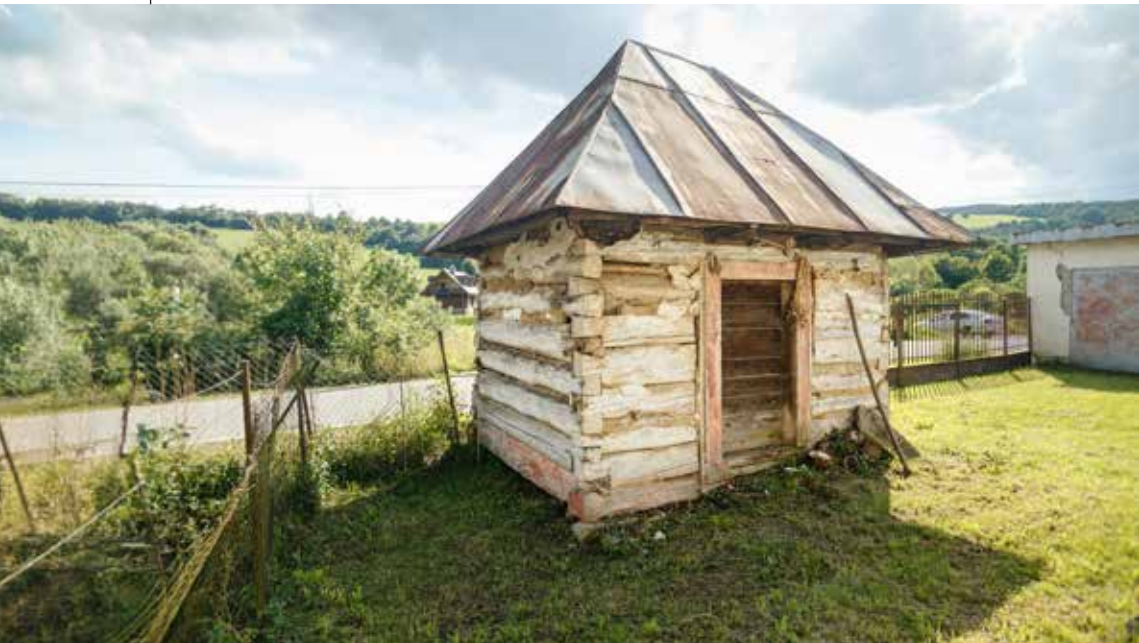
Varadka. Sypanec stojaci oproti domu pri ceste
