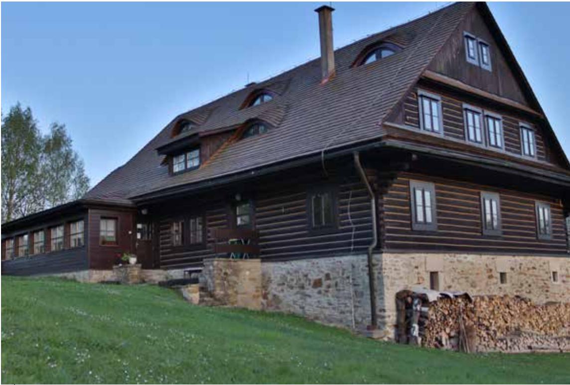
Roztoky. Veľká zrubová stavba z obdobia 1. Československej Republiky postavená pre potreby finančnej stráže
