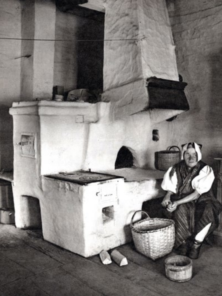
Udoskonalony kamienny piec pokojowy z paleniskiem, kominkiem i przybudowaną kuchenką. Zázrivá.
