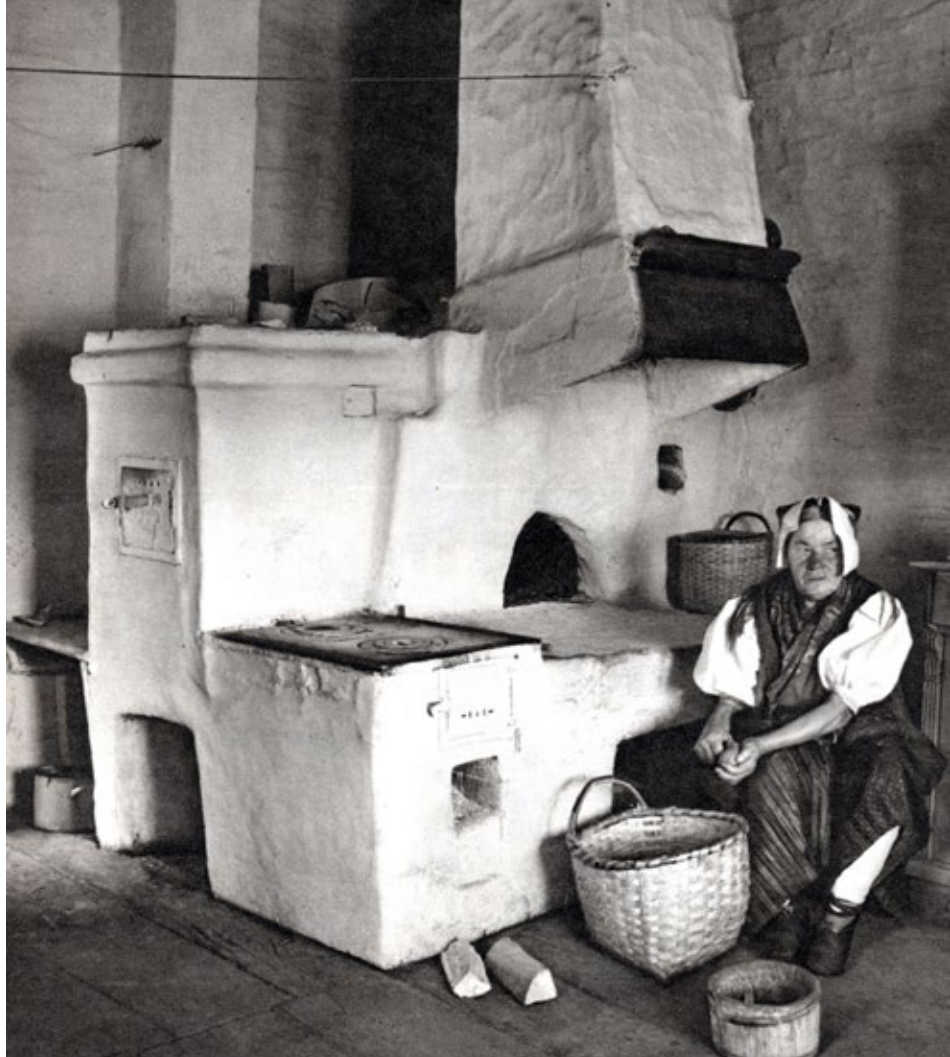
■ Zdokonalená izbová kamenná pec s ohniskom, kochom a pristavaným sporákom, Zázrivá
